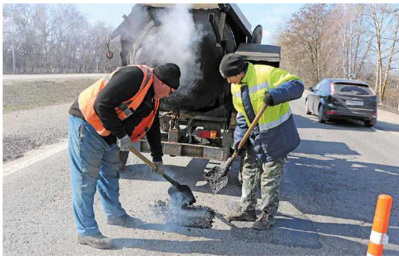
В первую очередь ремонтируют самые проблемные участки
